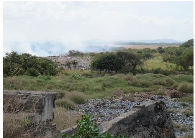
AGUO VERTEDERO DE AGUADULCE E INCINERADOR
